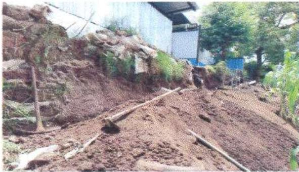
Foto 1: Ingreso al establecimiento donde se está sanjeando para la construcción del muro y colocación de columnas respectivas.
