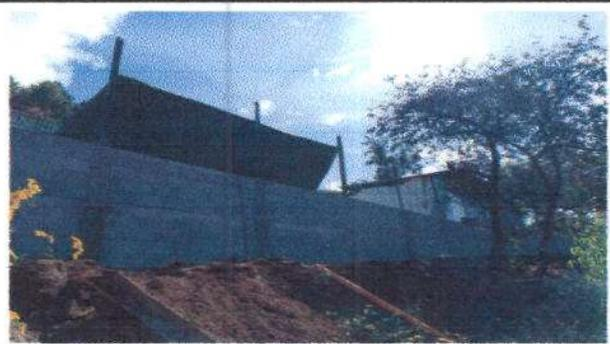
Foto 4: Vista de frente donde el muro se encuentra construido en un 85%.
