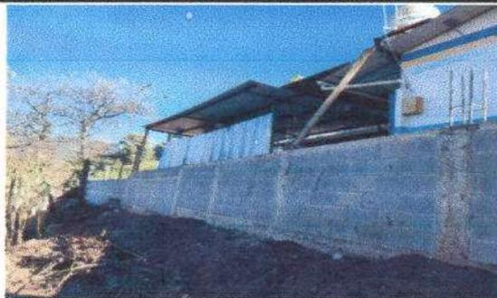
Foto 5: 37 Muro construido ya un 85% faltando su repello por dentro y sus respiraderos.
