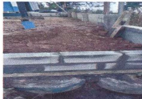
Foto 6: Debido al peso de personas particulares se creó una ondonada, en esta foto se observa que se está rellorando con tierra para la construcción del piso y se han quitado las láminas de color blanco y azul para poder fundir.
